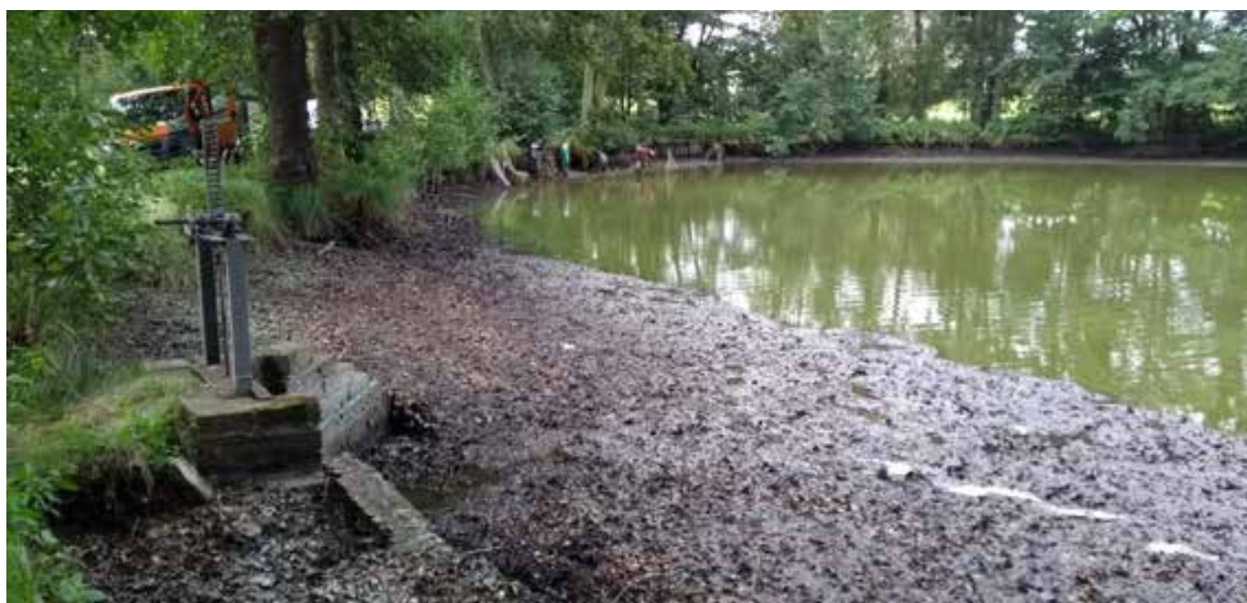
Blick vom Ständerbauwerk (stark verschlammte), im Hintergrund: laufende Abfischung
